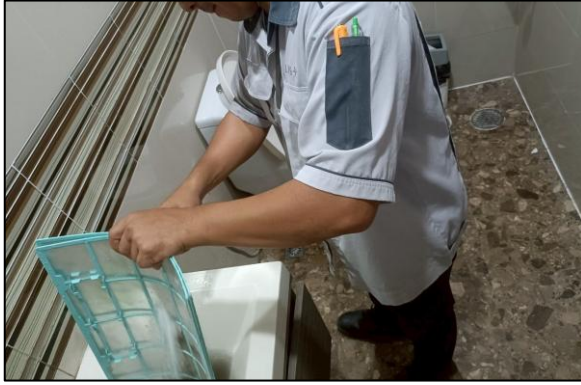
รูปภาพที่ 2.58 การทำความสะอาดเครื่องปรับอากาศ
