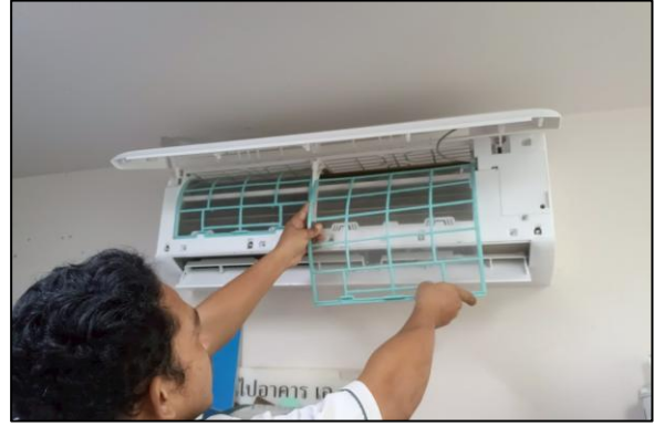
รูปภาพที่ 2.58 การทำความสะอาดเครื่องปรับอากาศ
